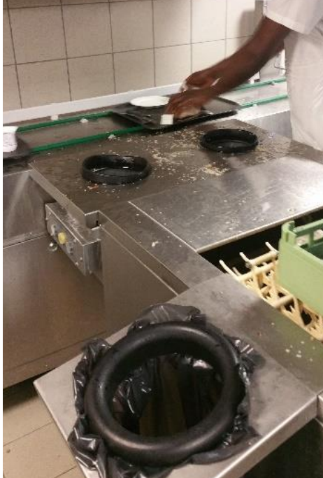
Collecteur installé sous les goulottes de tri :
